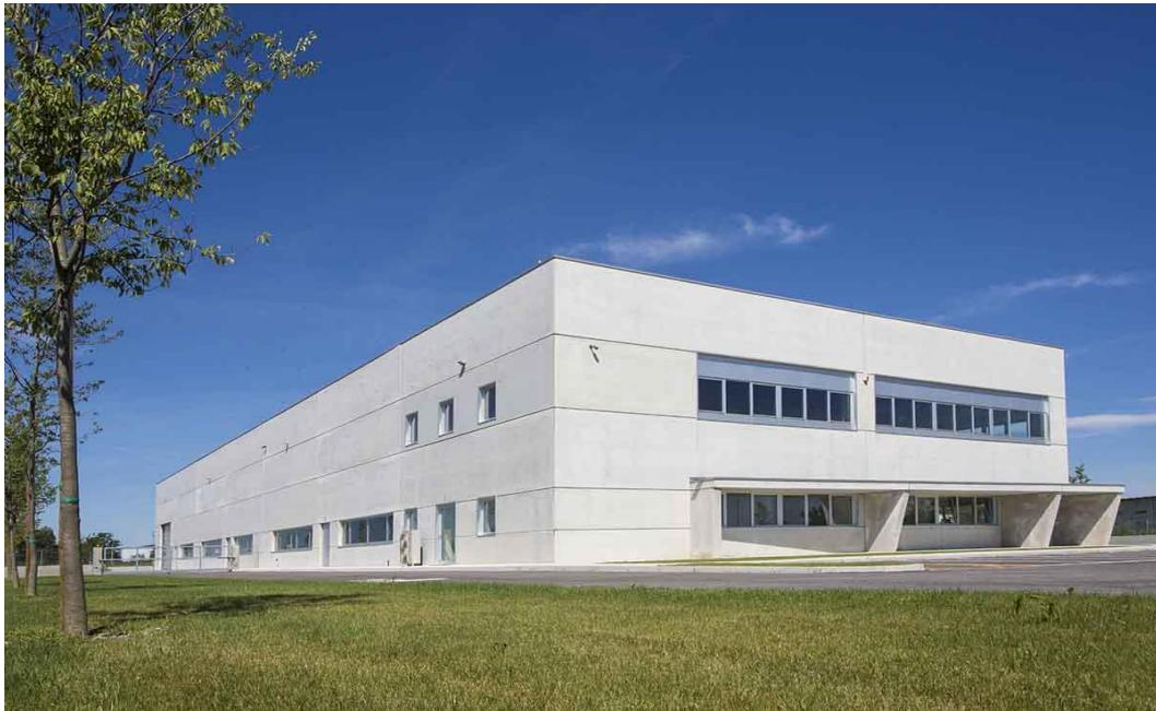
Capannone industriale edificato nel 2016 avente struttura prefabbricata ad un piano con copertura piana.
