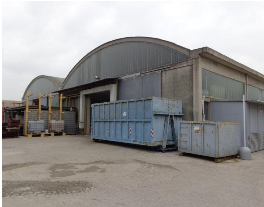
Capannone industriale edificato nel 1980 avente struttura in c.a. ad un piano con copertura a volta e presenza di tiranti interni che ne limitano l'utilizzo.
