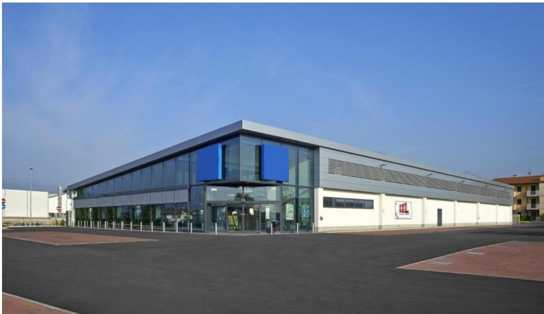
Edificio destinazione commerciale (grande magazzino) edificato nel 2010 avente struttura prefabbricata pesante ad un piano con copertura piana.
